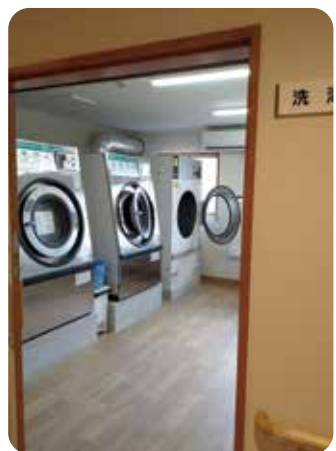
機能的になった洗濯室
